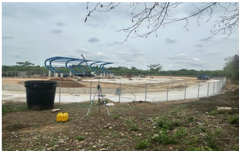
Construcción Pista de Patinaje de Chibolo
