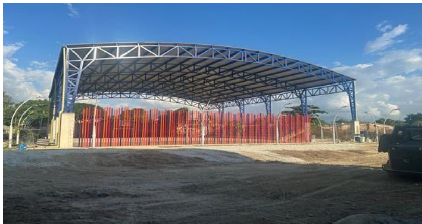
Construcción Cancha Multifuncional de Aracataca
