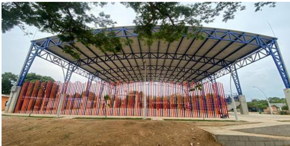
Construcción Cancha Multifuncional de El Banco
