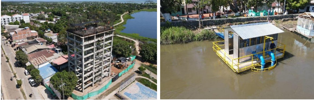
Construcción de optimización y ampliación del acueducto de El Banco
