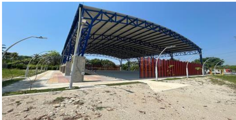
Construcción Cancha Multifuncional de Ciénaga
